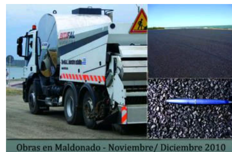
Obras en Maldonado - Noviembre/ Diciembre 2010
